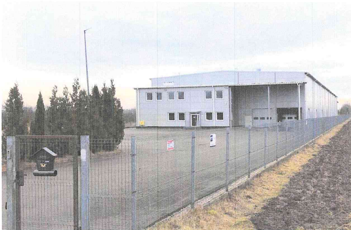
Rys. Widok od strony północnej
