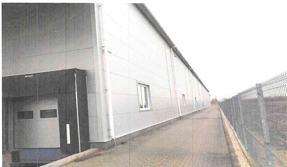
Rys. Widok od strony północnej
