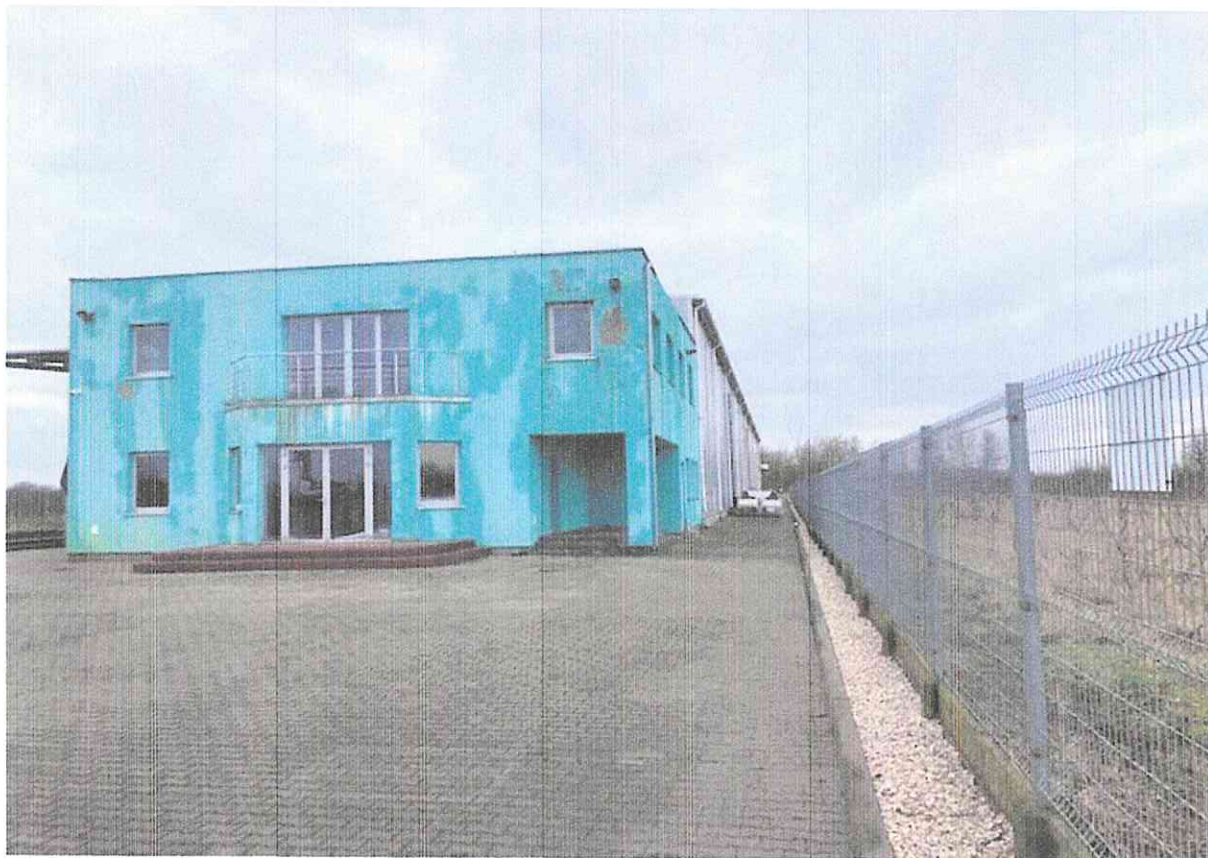
Rys. Widok od strony południowej
