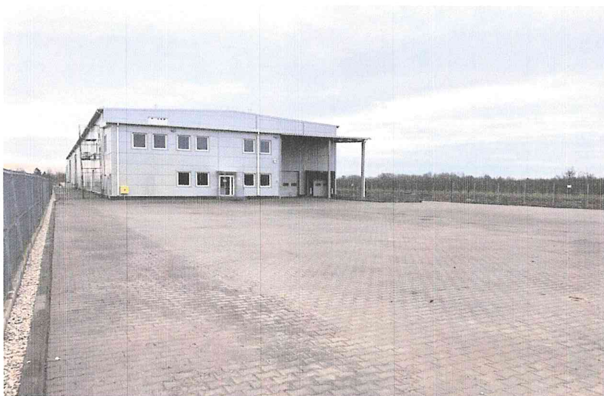
Rys. Widok od strony północnej
