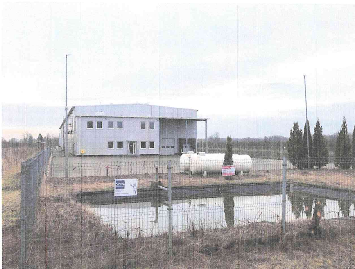
Rys. Widok od strony północnej, teren zbiornika chłonno-odparowującego, i okalająca go roślinność synantropijna (roślinność zielna, i tuje, rośliny sztucznie wprowadzona przez człowieka)
