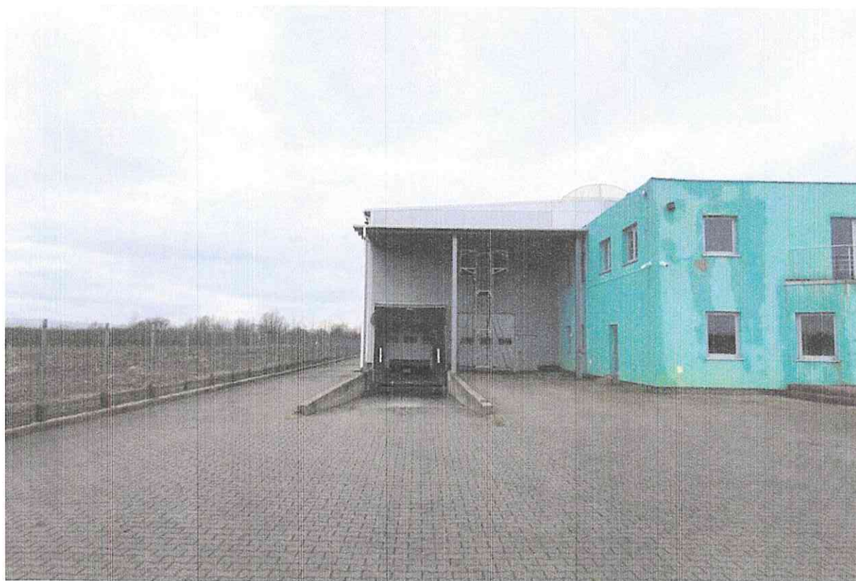
Rys. Widok od strony południowej
