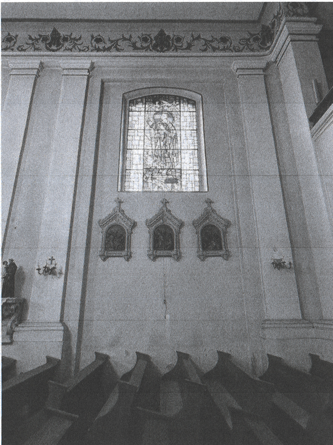
Fot. 3 Fragment ściany południowej obejmujący zabezpieczenie, konserwację i odnowienie części wnętrza kościoła, w tym uzupełnienie tynków w miejscu odnowienia
